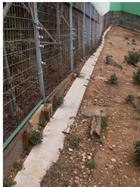
図10. 土掘り防止板（左：垂直に打ち込んだもの、右：水平に固定されたもの）
