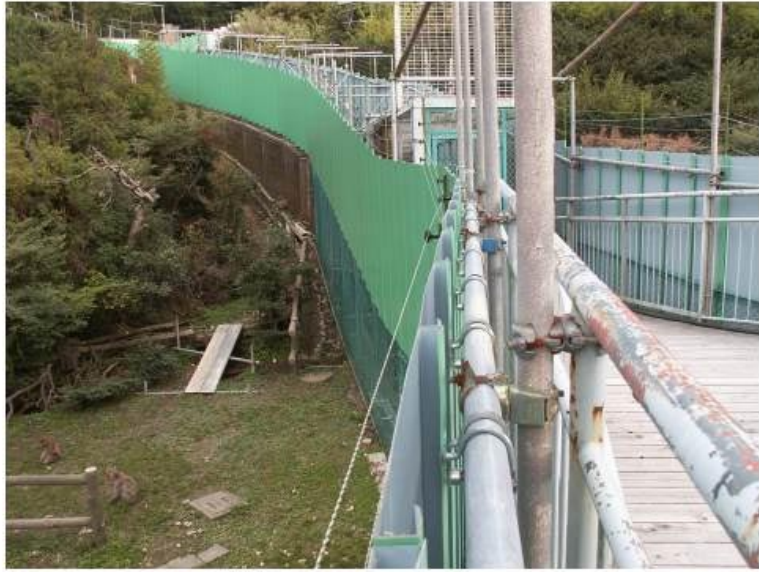
図11. フェンス上端部の電冊
