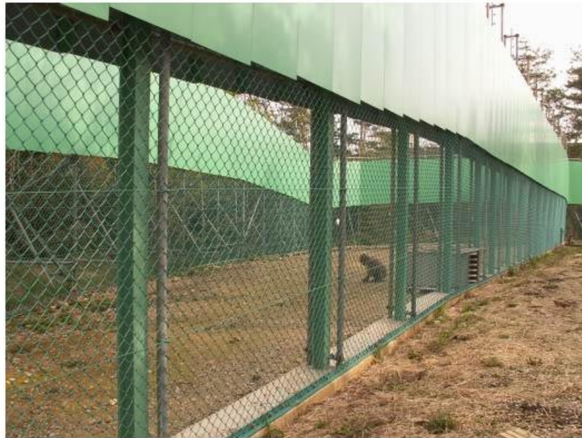
図9. 追い込み区画仕切りフェンス
