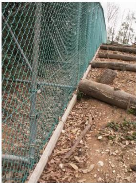
図10. 土掘り防止板（左：垂直に打ち込んだもの、右：水平に固定されたもの）
