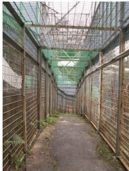
図4. 観察通路天井
