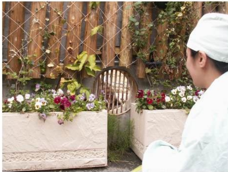
図5. コンクリートフェンスに設けられた通風孔
